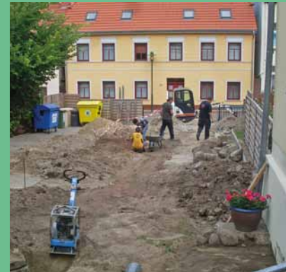
Der Innenhof des Kinderdorfhauses Wolgast war eine einzige Baustelle
